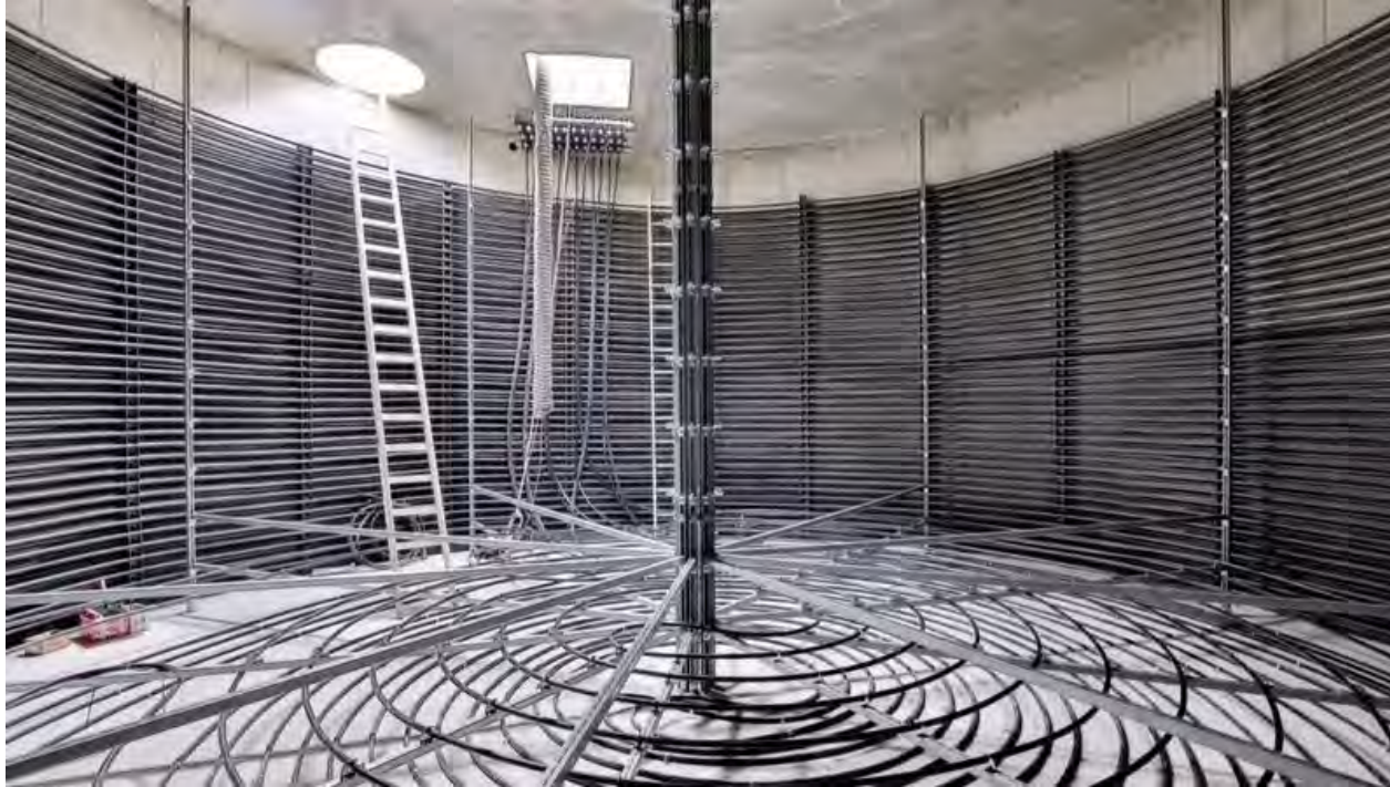
Eisspeicher im Bau für z.B. Wohnquartiere, Behältervolumen ca. 150 m 3 , Rundbehälter in Ortbetonbauweise
