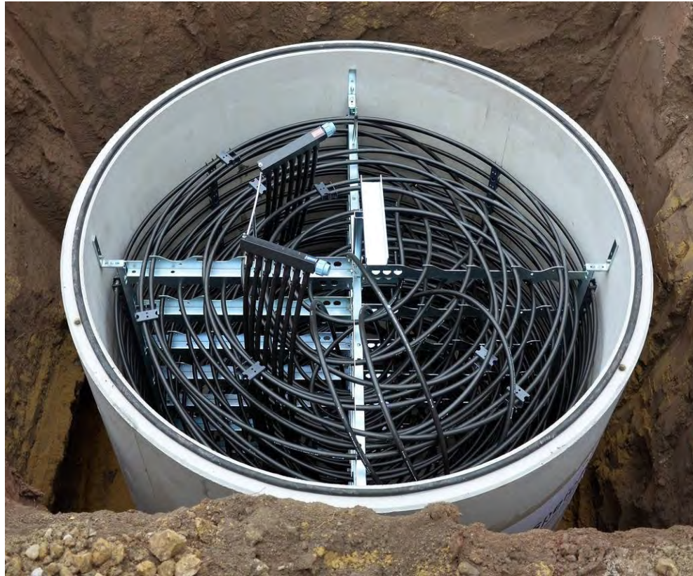
Eisspeicher für Einfamilienwohnhäuser, Behältervolumen ca. 10 m 3 Behälter als Stahlbetonfertigteilebehälter
