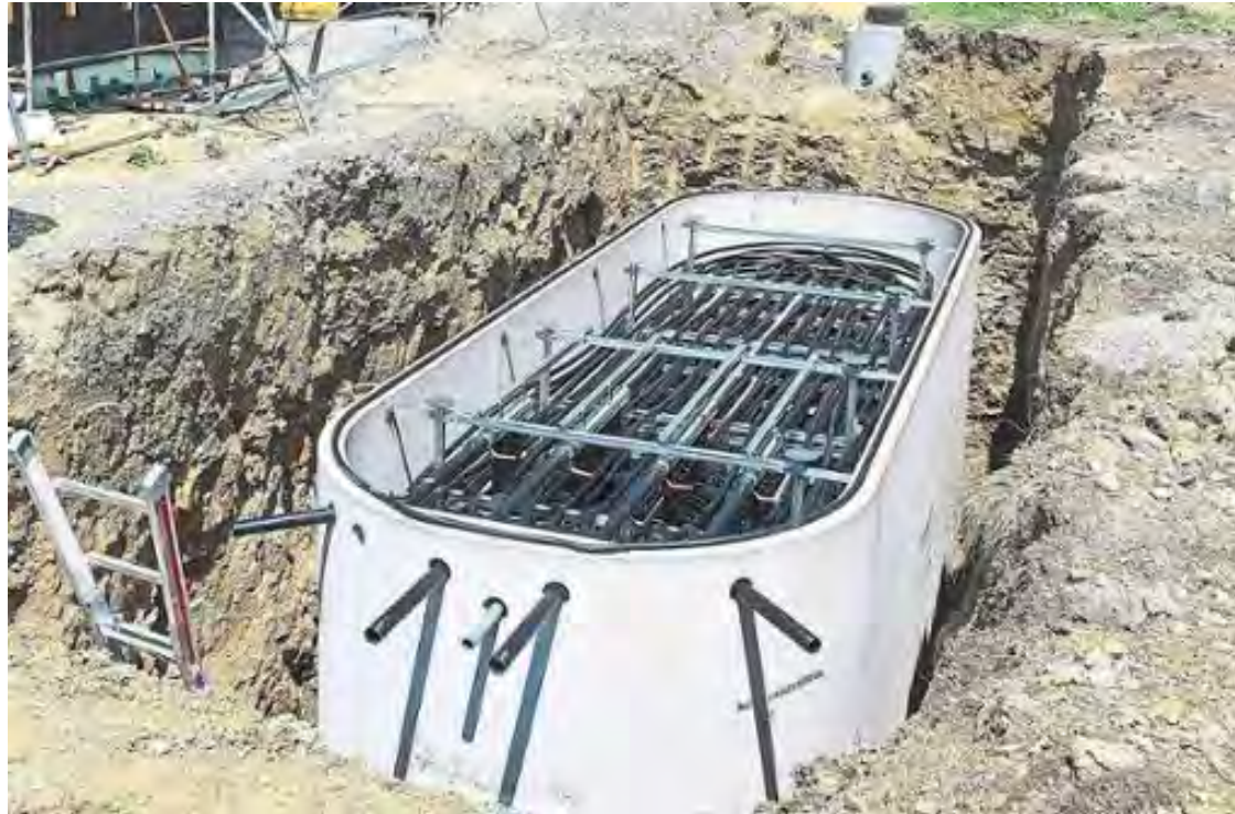
Eisspeicher z.B. für Mehrfamilienhaus, Behältervolumen ca. 20-30 m 3 , Behälter oval, Behälter als Stahlbetonfertigteilebehälter
